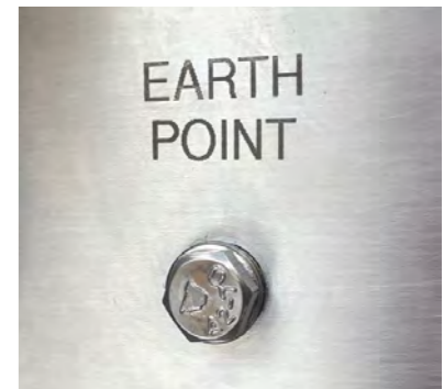
Le point de mise à la terre
